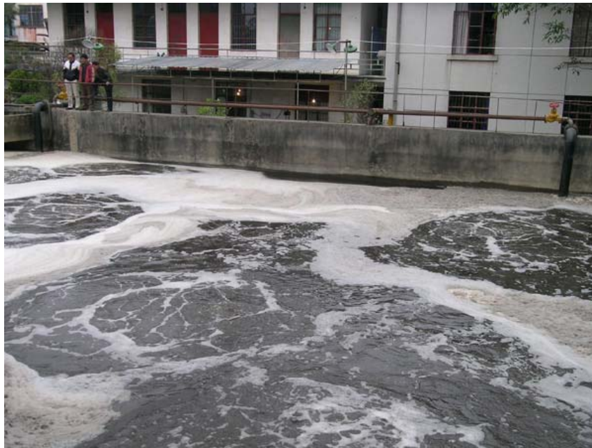
GW射流曝气运行时水流态（蔗糖酒精废水）
