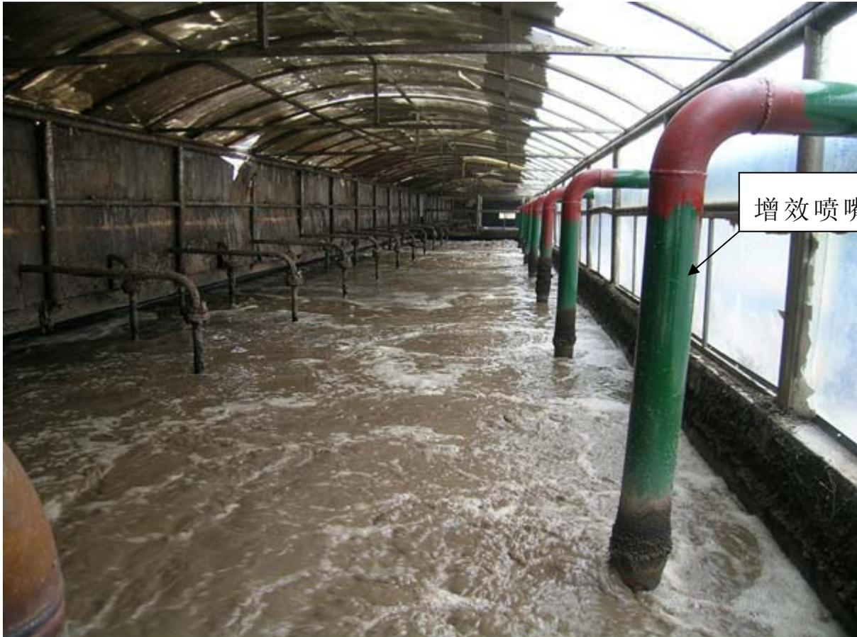
GW 鼓风加压射流曝气运行水面流态
