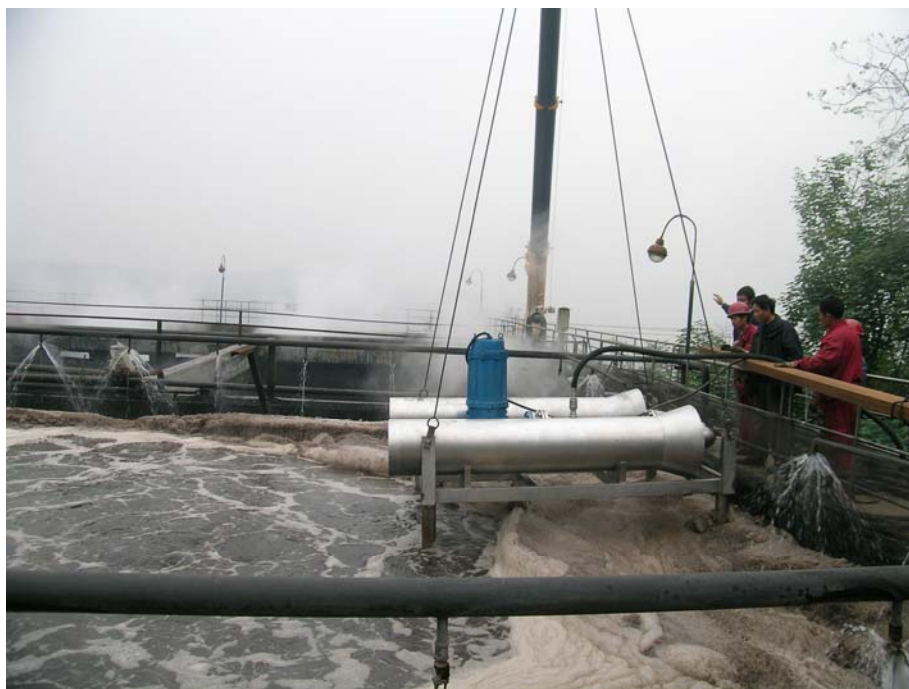
图2 GWQ扩散器吊装图
